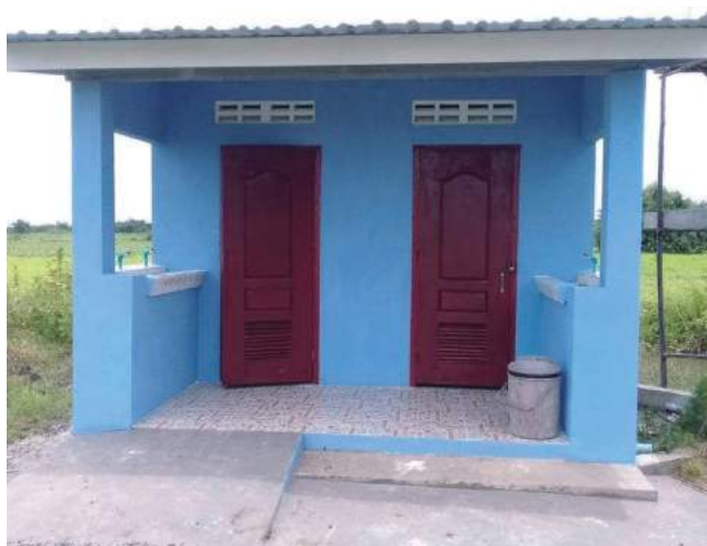
スカイブルーの清潔なトイレが完成
