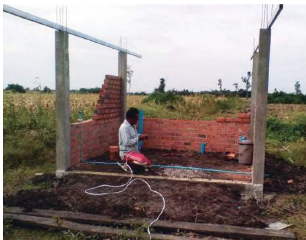
トイレ建設スタート
